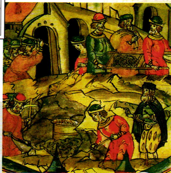
Строительство колокольни Ивана Великого в Московском Кремле
