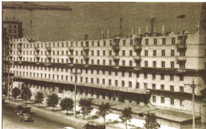
Строительство типового жилого дома в Москве
